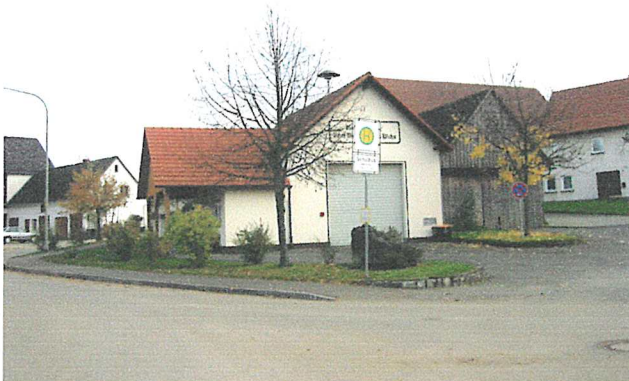
Blickrichtung nach Osten, zum Feuerwehrhaus
