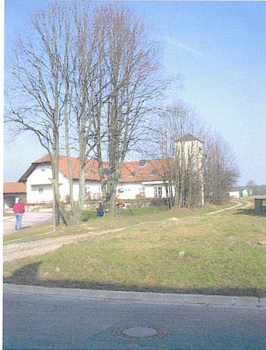
Ehemaliges Trafo-Haus rechts im Bild
