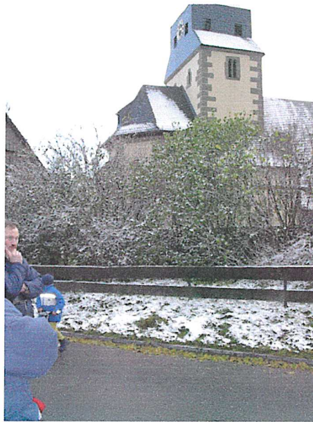
Ansicht Gehölz vor der Mauer
