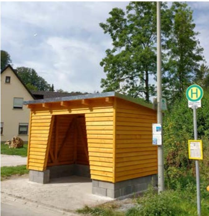
In **Kleinziegenfeld** wurde das in die Jahre gekommene **Buswartehaus** abgebrochen. An gleicher Stelle wurde ein neues Buswartehaus errichtet. Die Rückwand des aus Holz gebauten Buswartehauses wird durch Sichtfenster den Blick auf den Einlauf der Weismainquelle ermöglichen. Alle Arbeiten für dieses Projekt fanden in Eigenleistung statt.
