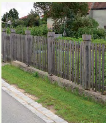
Aus einem Guss: Die Zaunfelder sind hier zwischen Holzpfosten gesetzt. Das gibt dem Gesamtbild einen gleichmäßigen Rhythmus.
