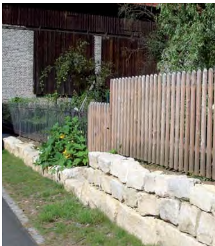
Materialwechsel von Metall zu Holz. Der Steinsockel ist das verbindende Element.
