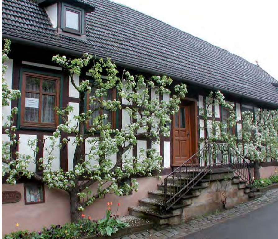
Birnenpalisaden gehören zu den traditionellen Fassadenbegrünungen in Oberfranken.
