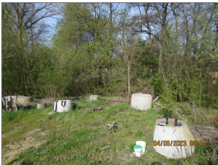
Bild-Nr. 2: Untersuchungsbereich mit markierter Schurfstelle ca. 15 m östlich der Krassach (Hintergrund).
