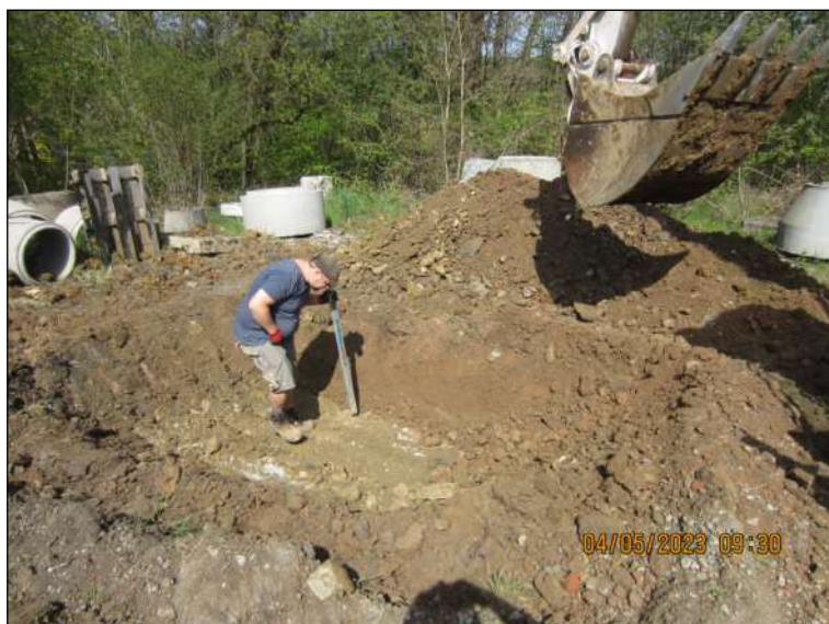
Bild-Nr. 5: Erweiterung von Schurf 1 für den Versickerungsversuch.
